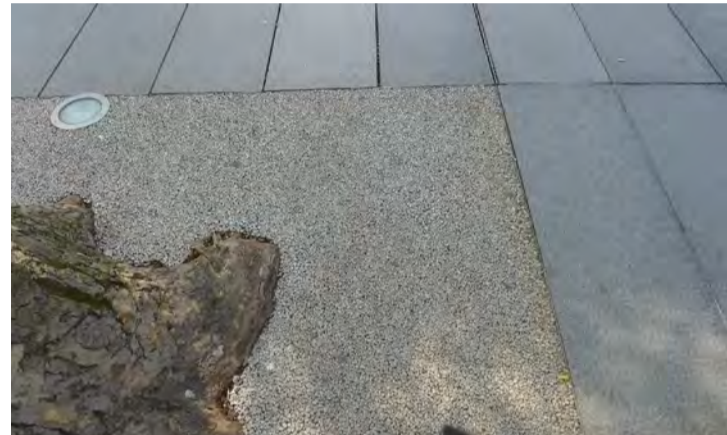
Raccordo di mitigazione fra la nuova pavimentazione e le alberature esistenti con ghiaia sciolta
