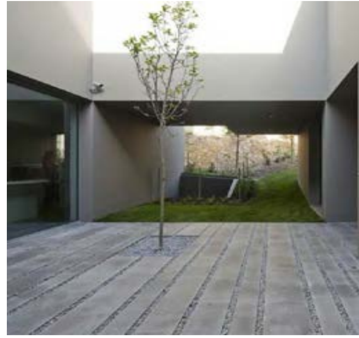
Lastre di cemento intervallate da fasce di ghiaia sciolta
