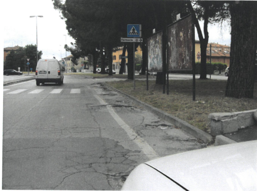
Viale del Lavoro – Via Ancona
