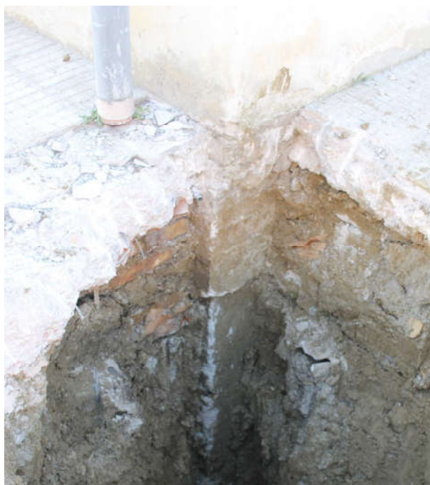
Foto 3: Sondaggio in fondazione
