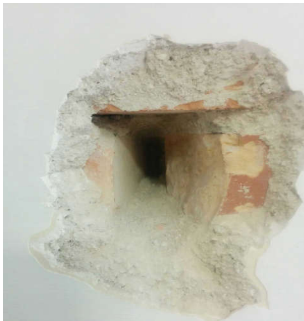
Foto 2: Saggio su tamponature - P. seminterrato
